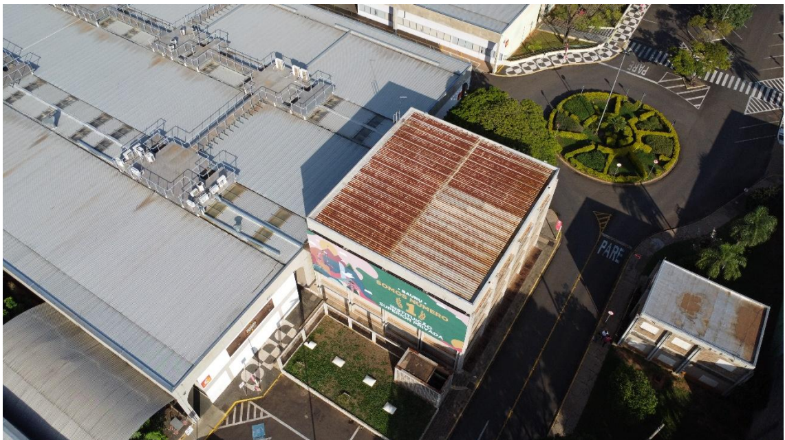
Figura 2 – Vista Aérea Cobertura, Rotatória e Teatro Veritas
