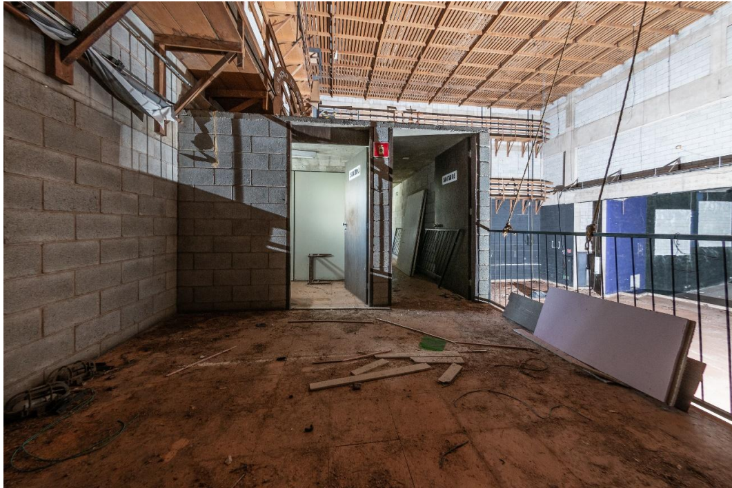
Figura 21 – Vista Interna de Acesso aos sanitários no Mezanino Presente no Palco
