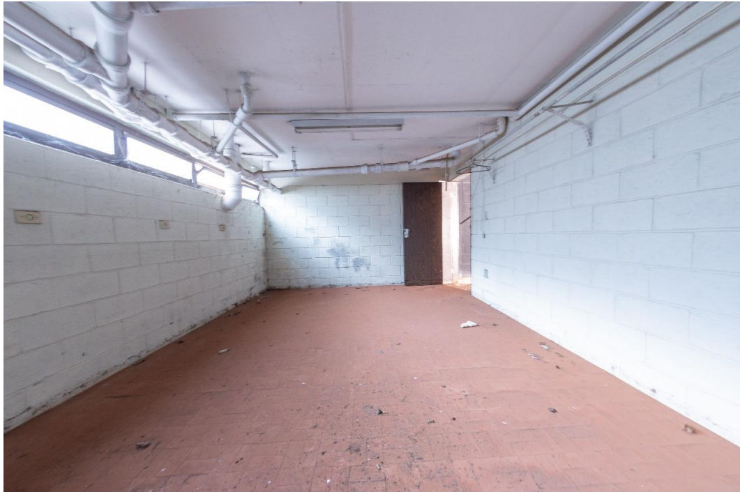
Figura 19 – Vista Interna Acesso ao Camarim Masculino
