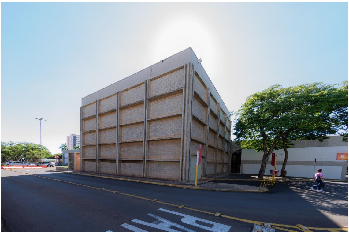
Figura 8 – Vista Posterior Teatro Verita Acesso dos Cenários
