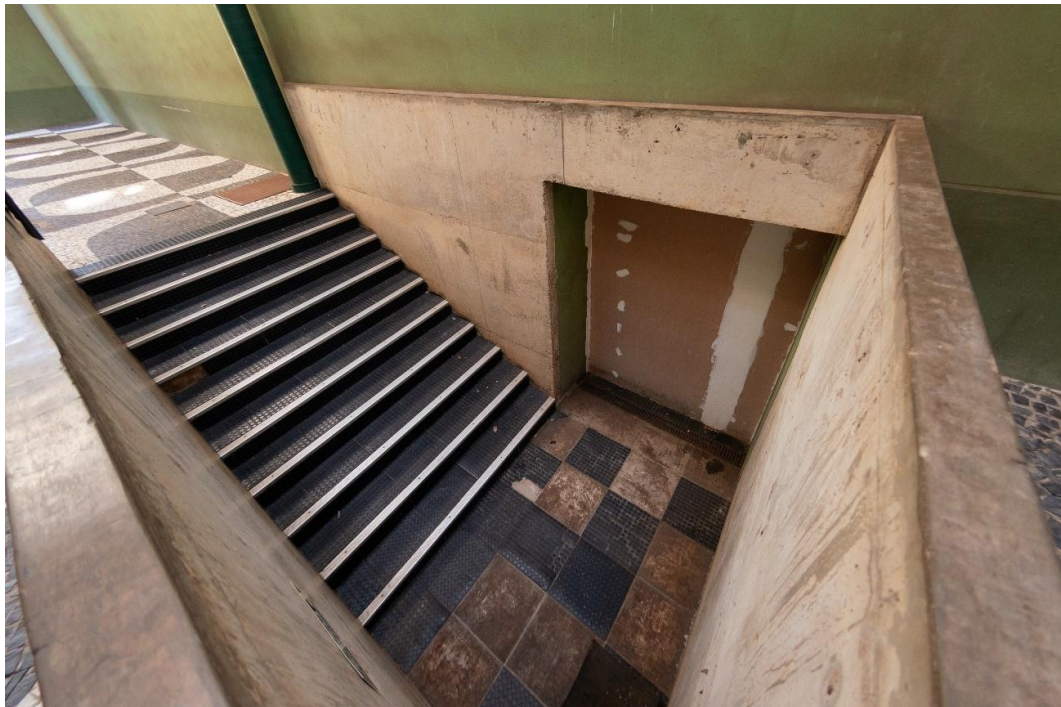
Figura 30– Acesso Lateral Esquerda do Acesso Principal Teatro Veritas
